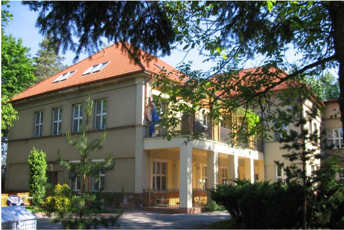
DC Veská – hlavní budova
